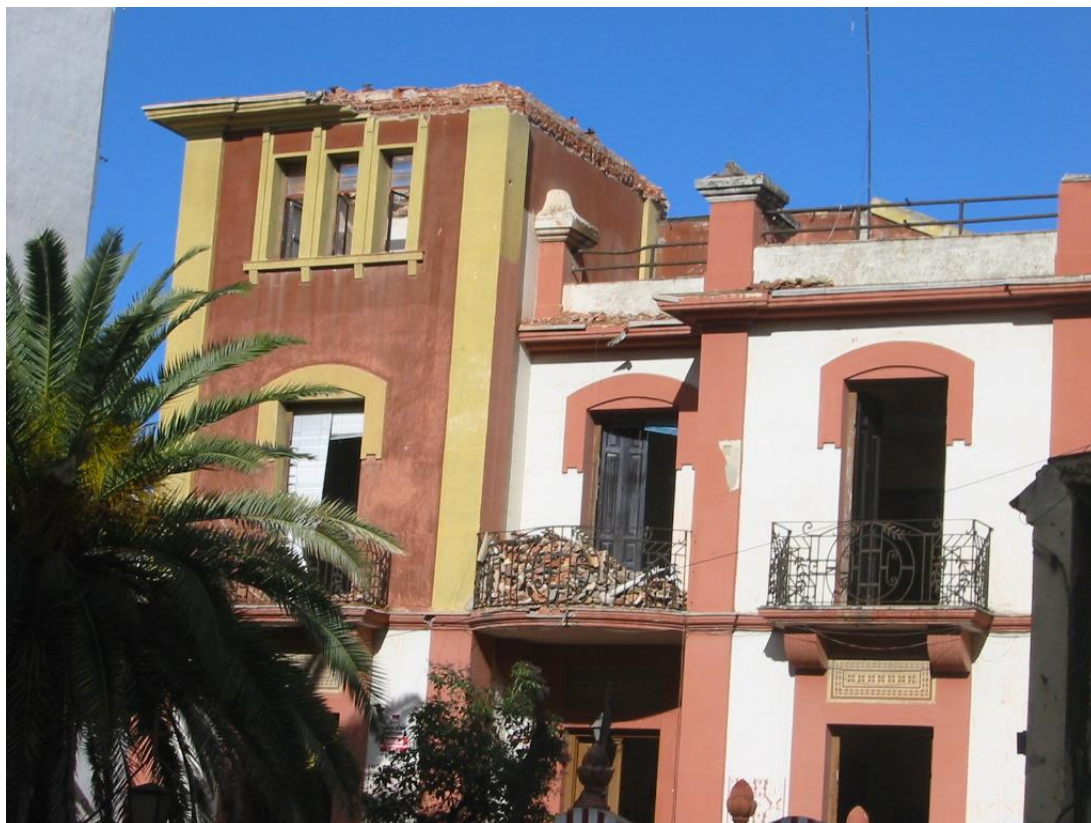
ESTADO DE LA DEMOLICIÓN TRAS SU SUSPENSIÓN
