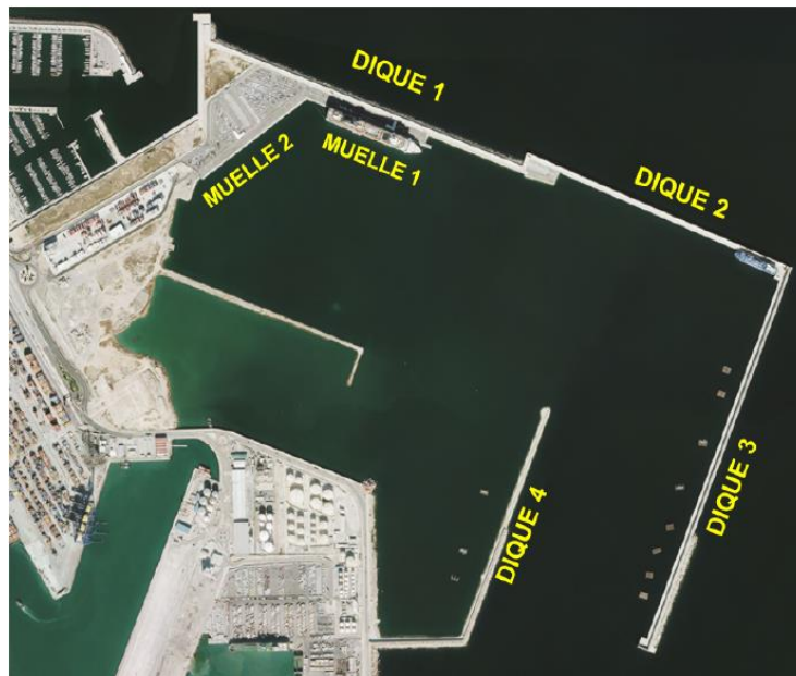
Figura nº3: Estado actual de las obras
